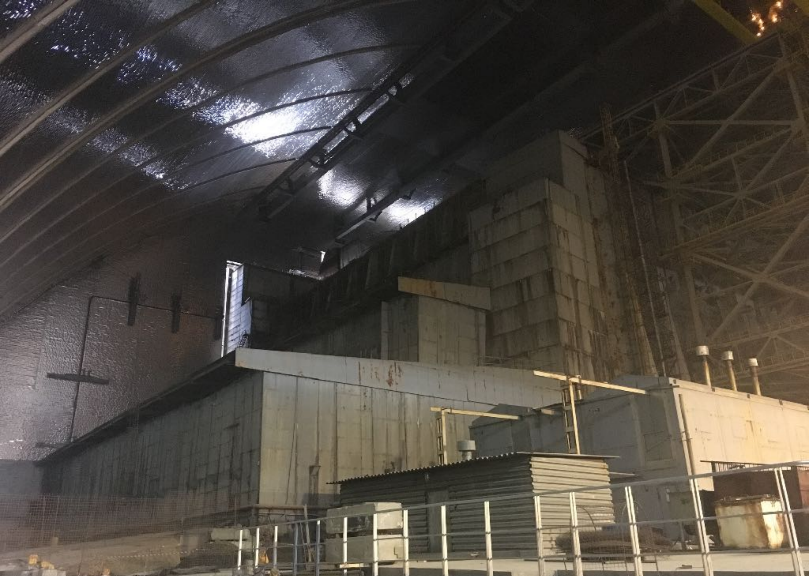
CONSTRUCTION DE LA NOUVELLE ARCHE
